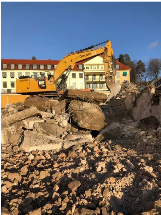
Bilde 3: Bildet viser rivearbeider ved Radiumhospitalet, Oslo universitetssykehus HF
